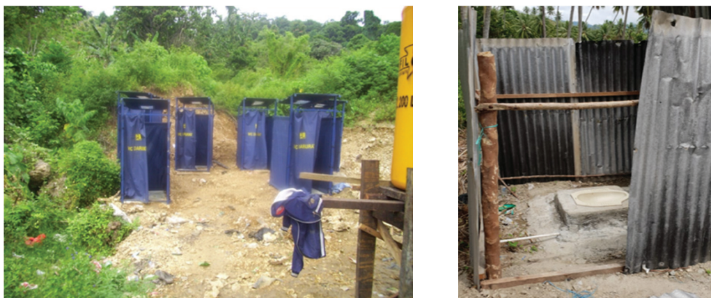
Foto 2: Kiri: Toilet darurat, tidak terpisah laki-laki dan perempuan, tidak ada penerangan, tidak bisa ditutup rapat dan dikunci, pengungsian banjir Wassior di Manokwari, 2011. Kanan: Toilet di salah satu tempat pengungsian di Sulawesi Tengah yang tanpa pintu dan tanpa penerangan, 2018
